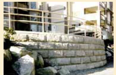
曲線部の施工
