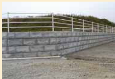
フェンスを立てる現場
