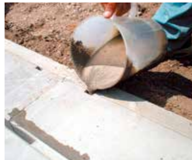
特殊モルタルで固定化
