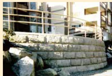
曲線部の施工
