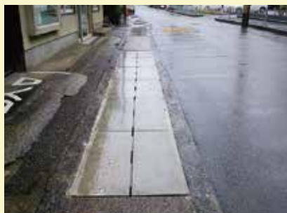
大阪府八尾市
