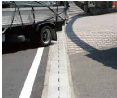
現場打ち側溝
