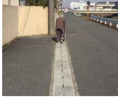
現場打ち側溝
