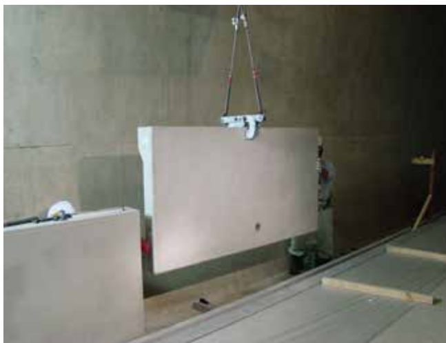
③ 専用吊金具にて据付作業
