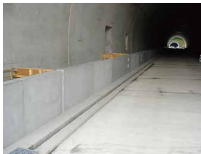
トンネル内部から出口を臨む
