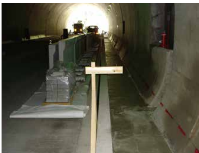
② 均しコンクリート打設
