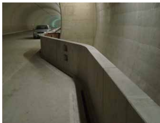
非常駐車帯②
