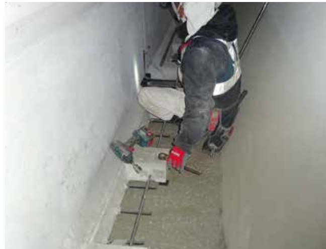
④ 製品据付 高さ調整
