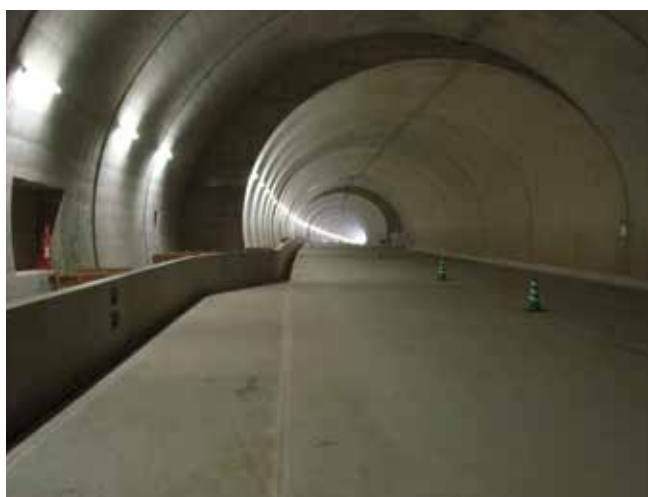
非常駐車帯①
