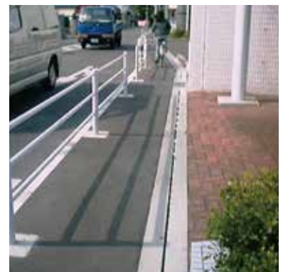
歩道整備事業 (大阪府阪南市)
