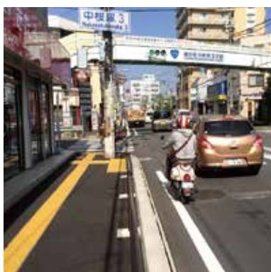
電線共同溝 (国道176号大阪府豊中市)
