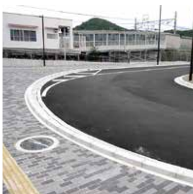
駅ロータリー整備 (兵庫県妻鹿駅)
