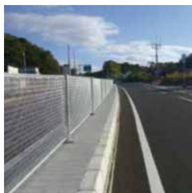
中央分離帯 (国道170号大阪府和泉市)
