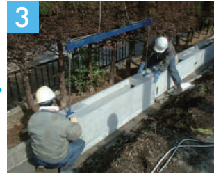
専用吊金属にて製品の据付
