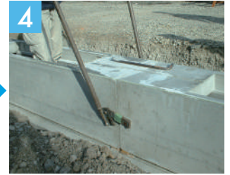
パーフェクトジョイント工法により製品を引寄せ、連結完了
