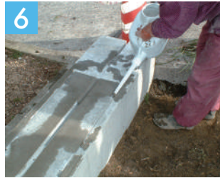
頂版の切欠部に充填材を注入し養生
