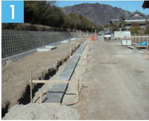
掘削をし、コンクリート基礎を打つ
