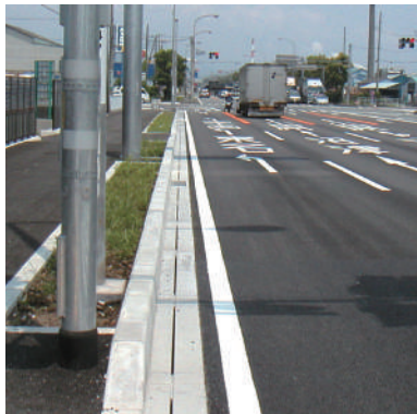
静岡県富士市(国道1号)
