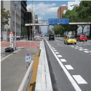
愛知県名古屋市(国道19号)
