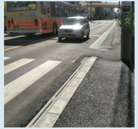
神奈川県横浜市 管内道路整備工事
