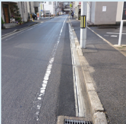
愛知県豊田市 道路維持修繕工事
