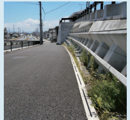
和歌山県和歌山市 南港山東線
