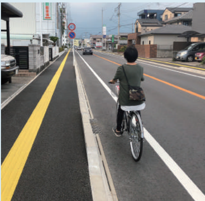
静岡県静岡市 上川原広野線
