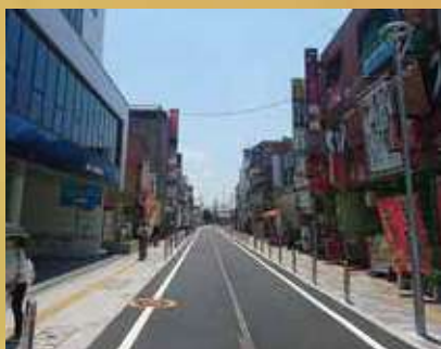
東京都昭島市 〈センター側溝〉
