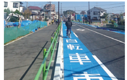
東京都東久留米市 ※JS接続ブロック使用
