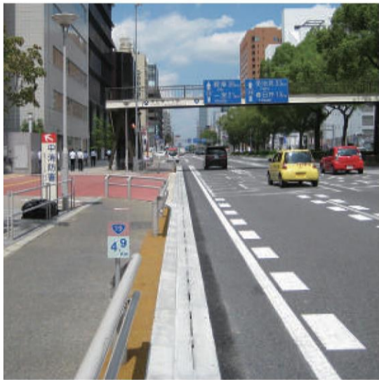
愛知県名古屋市(国道19号)
