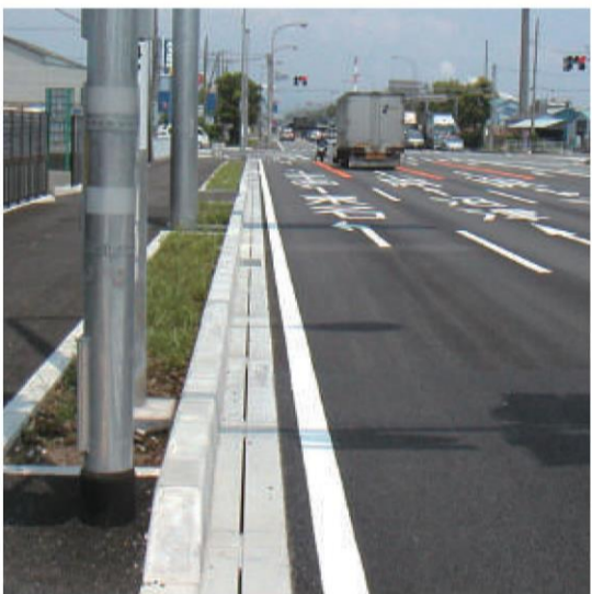
静岡県富士市(国道1号)
