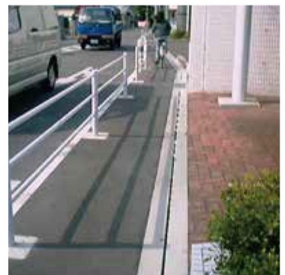
歩道整備事業 (大阪府阪南市)
