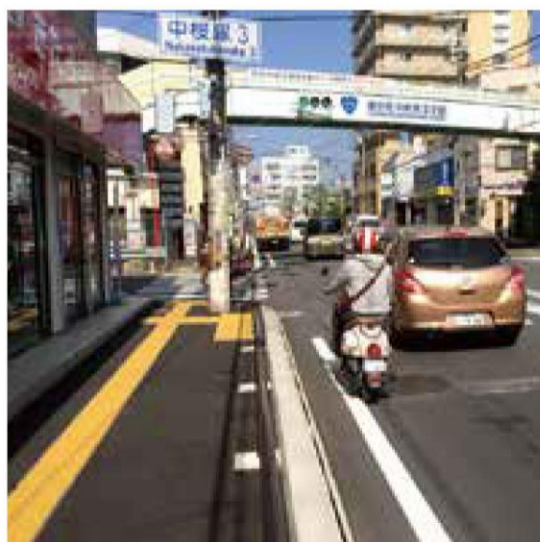
電線共同溝 (国道176号大阪府豊中市)
