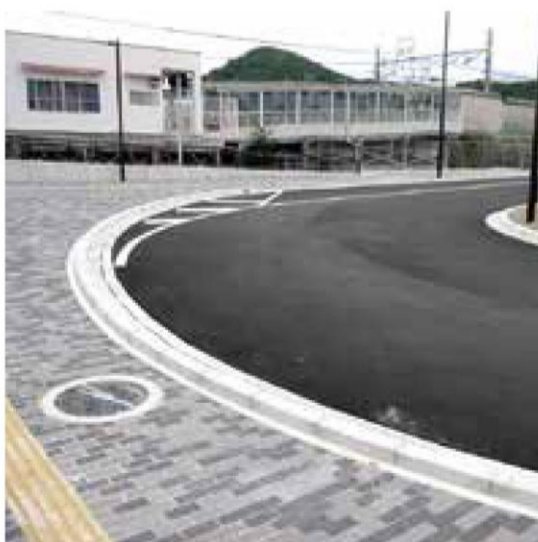
駅ロータリー整備 (兵庫県妻鹿駅)
