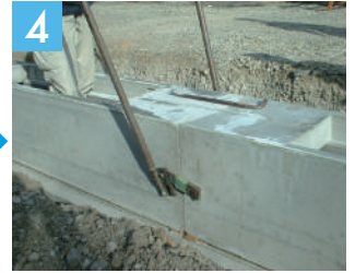
パーフェクトジョイント工法により製品を引寄せ、連結完了
