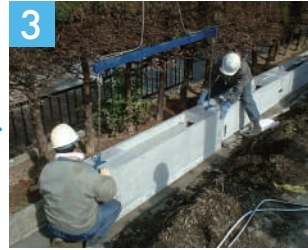
専用吊金属にて製品の据付
